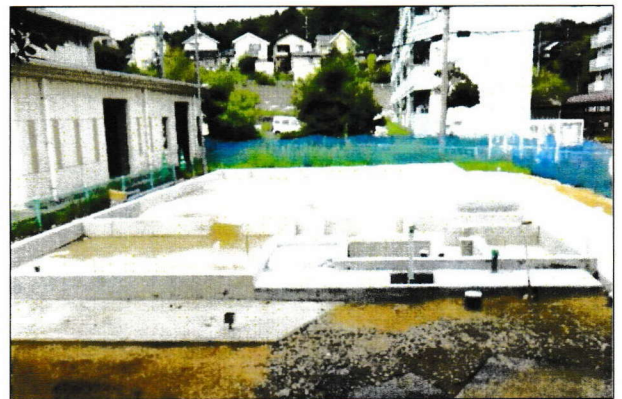
基礎工事 H29.8.26
